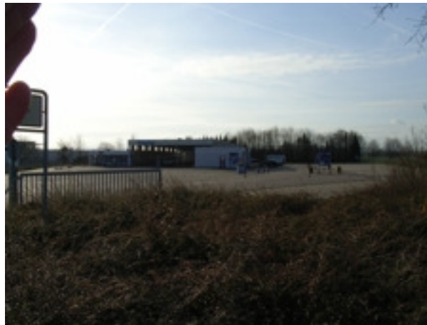
Blick von der Nenndorfer Straße nach Süden
