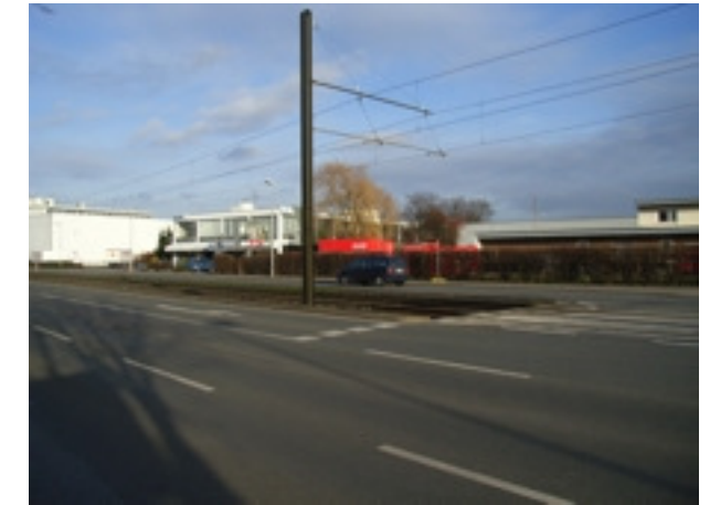
Betriebsgrundstück nördlich der Chemnitzer Straße
