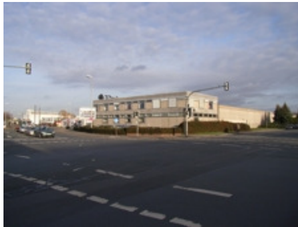
Leerstand, Berliner Straße / Nenndorfer Straße
