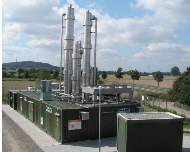
Abb. 29: Biogasaufbereitung in Ronnenberg
