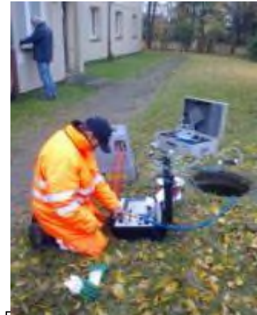
Abb.: Durchführung einer Luftdruckprüfung
