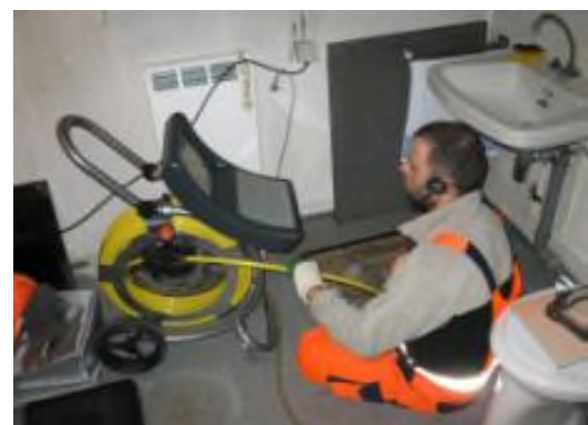
Abb.: Untersuchung mittels geschobener Kanalkamera von einer Revisionsöffnung aus
