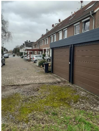
Auf dem Rade im Anschlussbereich an das Bebauungsplangebiet Nr. 131
