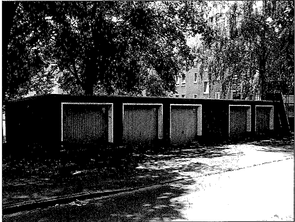
Garagenzeile in der Hallerstraße (Beispiel einer alten, inzwischen sanierten Garagenanlage)
