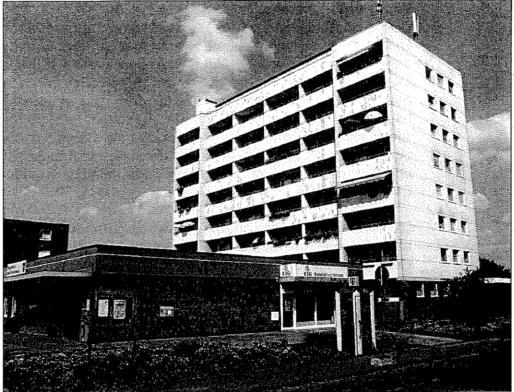
Löwenberger Str. 2 mit Bürgerbüro der Stadt Ronnenberg, Außenstelle der KSG, Seniorentagesstätte (im Hochhaus) im Jahr 2005 ...
