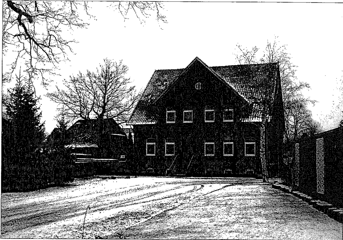
Ansicht von Norden
