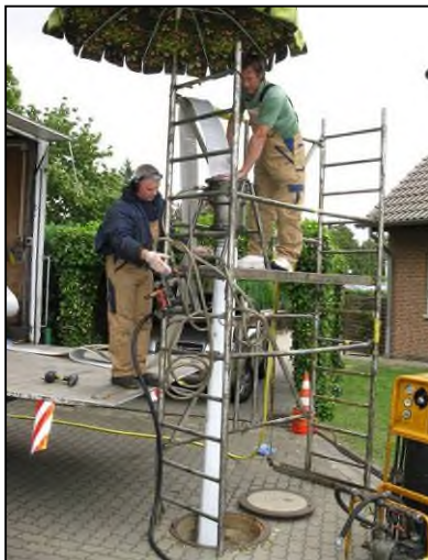
Abb.: Einbau eines Schlauchliners über einen Übergabeschacht [Anlagen für den Einbau innerhalb eines Gebäudes sind i. d. R. kleiner]
