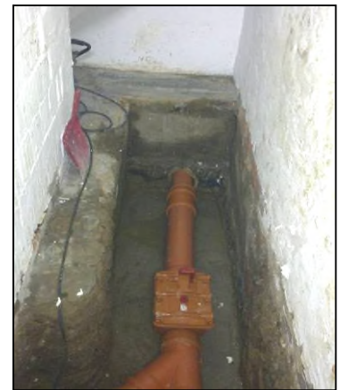
Abb.: eine erneuerte Abwasserleitung im Kelleraeschoss
