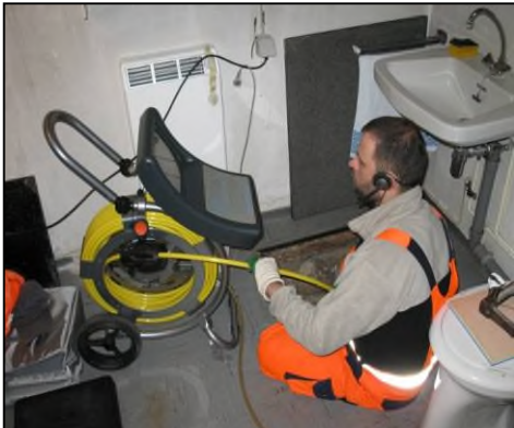
Abb.: Untersuchung mittels geschobener Kanalkamera von einer Revisionsöffnung aus
