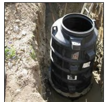
Abb.: Nachrüstung mit einem Kunststoffschacht
