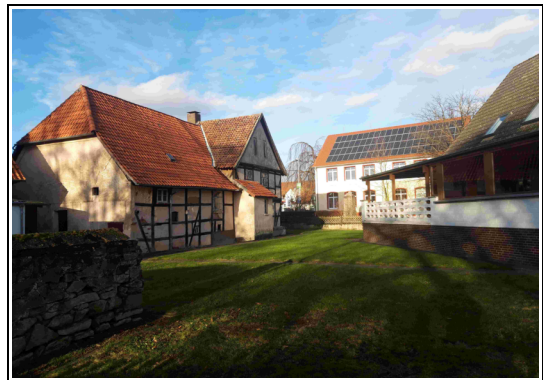
Wohn- und Mischbebauung (Hauptstraße 1 und 3)
