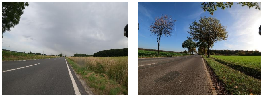
Abb. 3 Poggenburg (L 389) [links]; Hiddestorfer Straße (K 226) [rechts]
